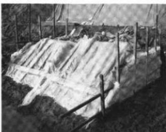
写真103 木製枠工の梱包作業
