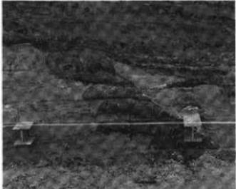
写真8 中柵地点第12層の土嚢積み
