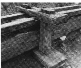
写真43 砂蓋を押さえるための柱
