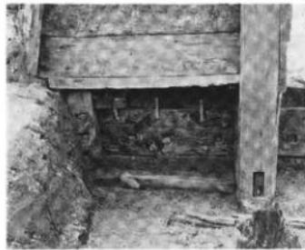
写真 31 取水部の基礎にされた東橋下層構
