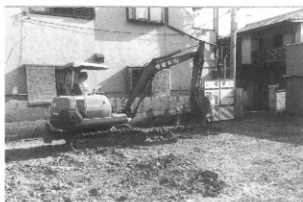
ショベルカーによる表土除去作業
