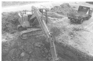
ショベルカーによる表土除去作業
