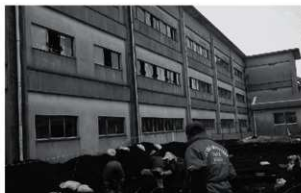
23. B地区調査状況
