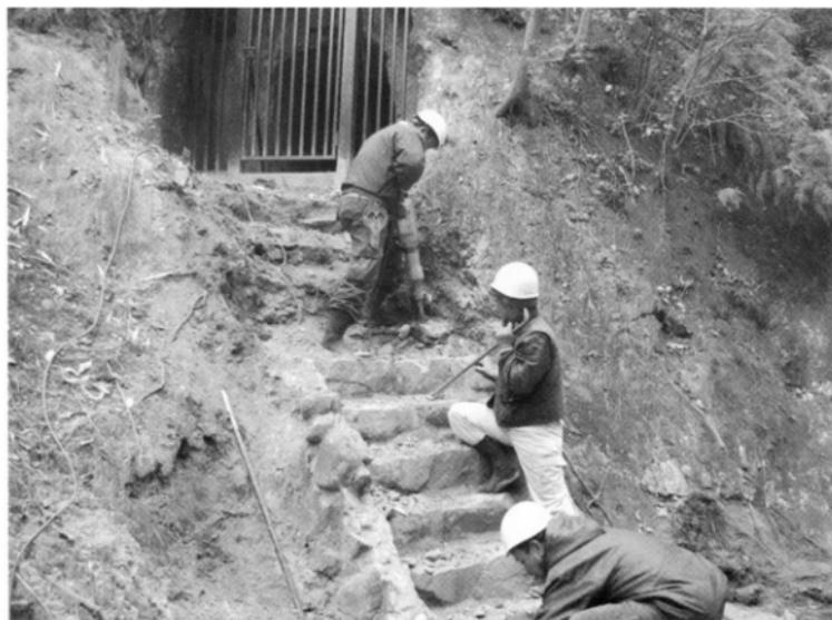
図版十三 新規階段基礎部掘削
