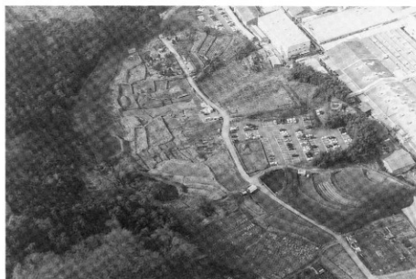
調査地全景 (東から)
