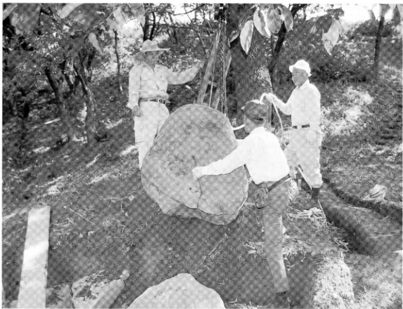
女室天井転落石の除去作業
