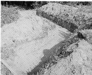
第5トレンチ掘削後
