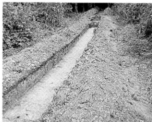
第9トレンチ掘削後
