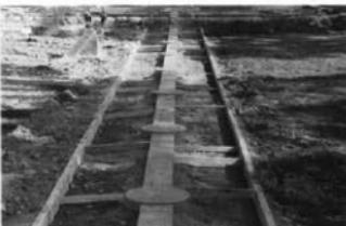
図109 第Ⅰ期塀の柱・軸木据付作業
