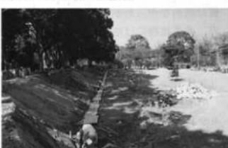
図105 皿形側溝据付作業
