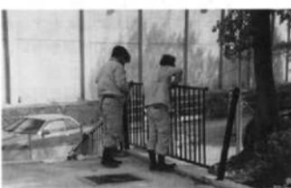
図104 パイプ柵取付作業
