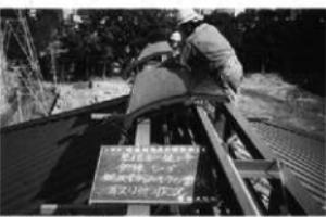
図69 飾り棟取り付け作業
