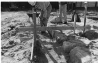
図113 第Ⅲ期建物基壇の縁石据付作業
