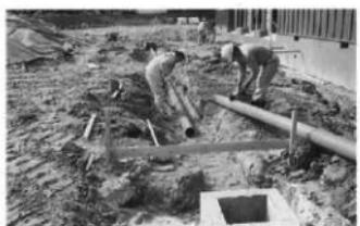
図106 排水ビニール管の付設作業
