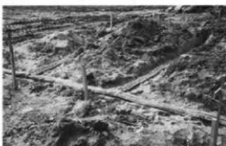
図107 透水管付設作業
