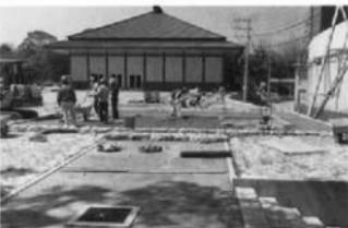
図108 第Ⅰ期真砂土舗装作業
