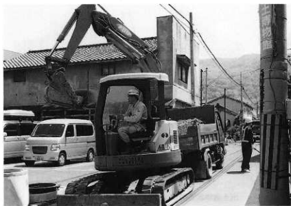
B-2 地区調査状況
