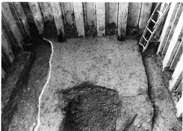
第2層上面落ち込み完掘状況 (東より)
