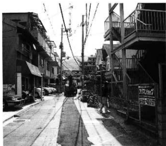
A地区調査地遠景
