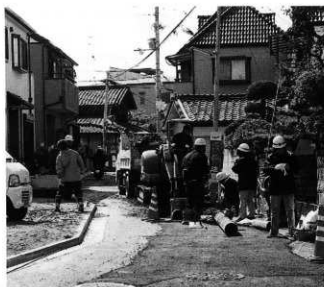
A地区調査地遠景
