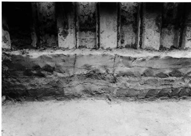
南壁断面 (第6～9層 北より)
