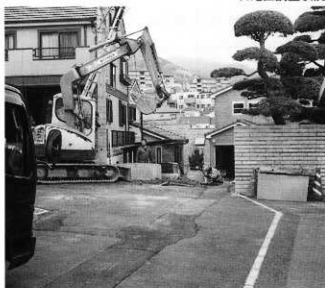
A地区調査地遠景
