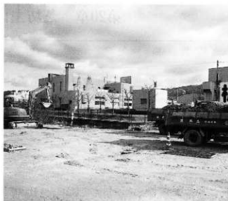
A地区調査地遠景
