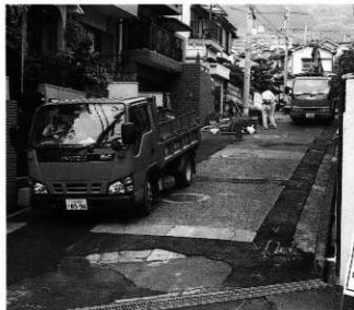
A地区調査地遠景
