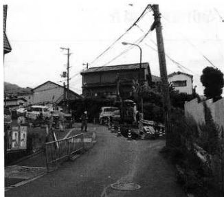
A地区調査地遠景
