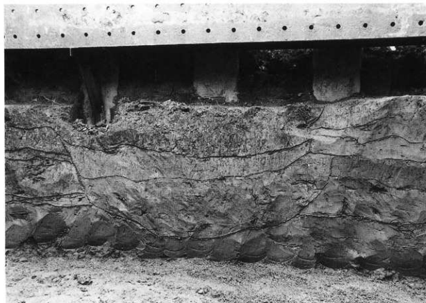
溝断面 (東より)
