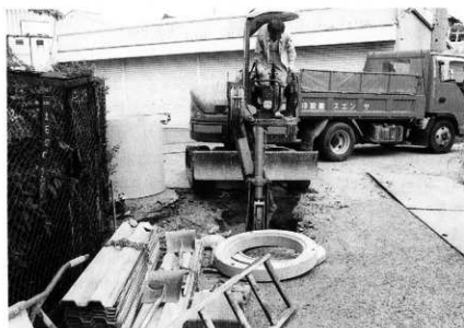
B地区調査状況
