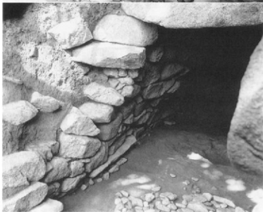
図57 石室左側壁（開口部から）
