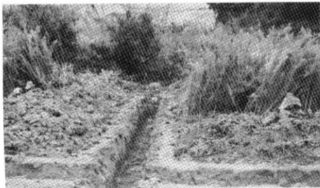
第2トレンチを望む 東から西
