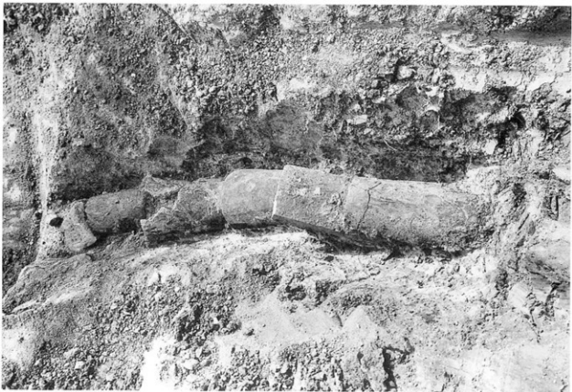
2. 3号窟 溝掘削状況
