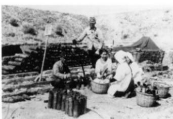
爆発による填薬弾の脱薬作業中の工具
