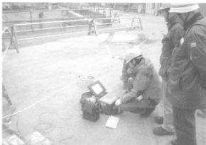
写真5 京都大学防災研究所による地震計を用いた地中探査
