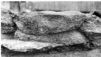
基礎部分の土依積み (足場状遺構 106：西から)
