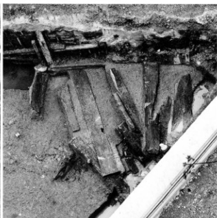
足場状遺構 113 (南から)
