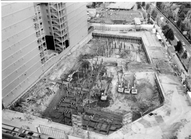
調査地全景（南から）
