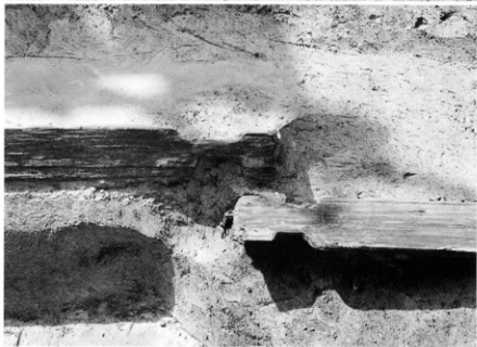
護岸遺構 188 細部 (東から)
