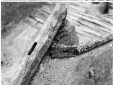
木組み細部（北東から）
