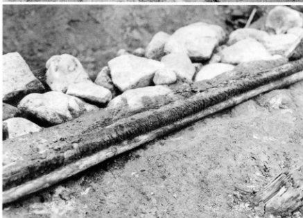
暗渠排水管 細部 (南西から)
