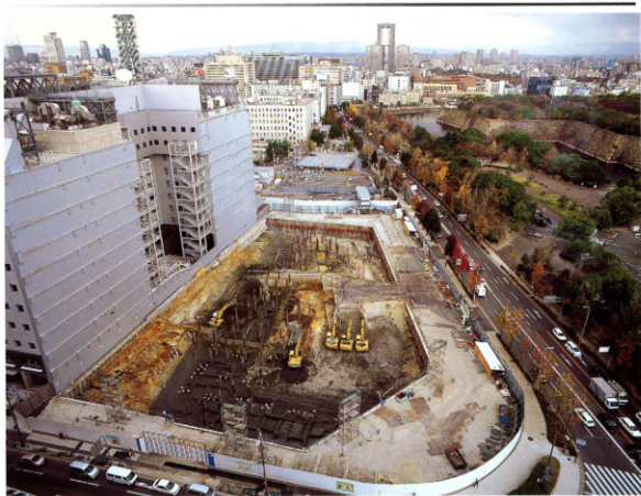
調査地全景（南から）
