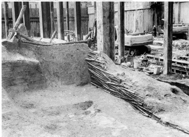
土塁と梁の残存状況(北東から)
