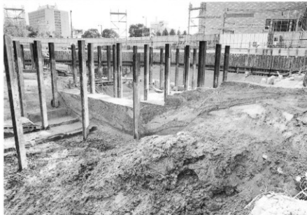
東西土層断面 (堀 83 西側：北西から)
