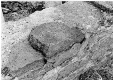
基礎部分の土依積み断面 (足場状遺構 106：南東から)
