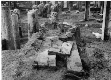
板敷き細部（南から）
