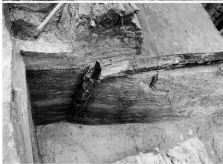
杭の折損状況（北から）
