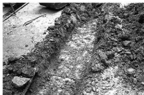
第35図 トレンチ掘削状況
