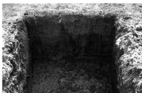
第 65 図 トレンチ掘削状況
