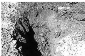
第 97 図 トレンチ掘削状況
