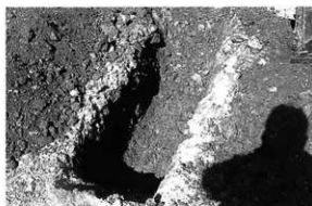
第53図 トレンチ掘削状況
