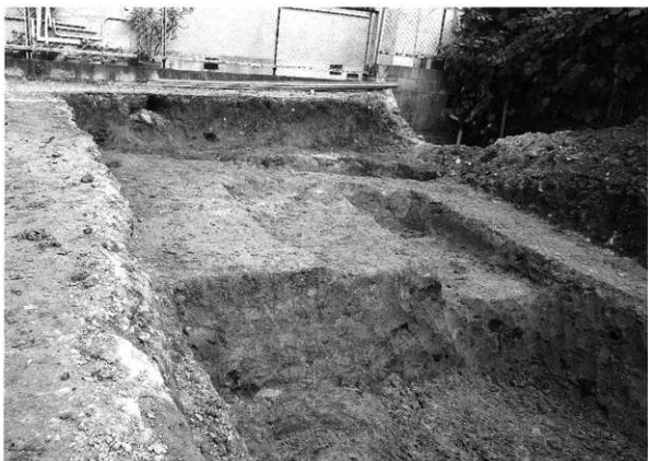
(2) 第 11 次調査 調査区掘削状況 (北東から)
