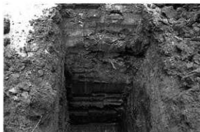
第 67 図 トレンチ掘削状況
