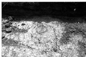
第 85 図 トレンチ掘削状況
