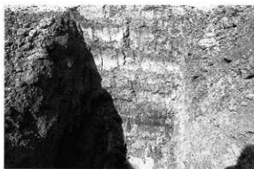
第59図 トレンチ掘削状況
