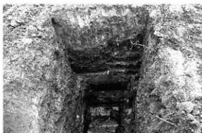
第45図 トレンチ掘削状況
