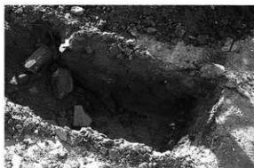
第 39 図 トレンチ掘削状況
