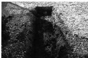
第 101 図 トレンチ掘削状況
