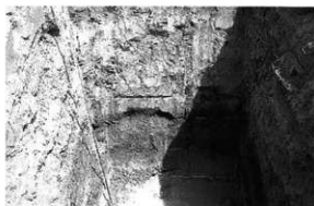
第 57 図 トレンチ掘削状況
