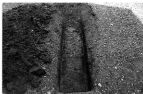
第 49 図 トレンチ掘削状況
