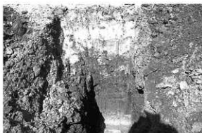
第 63 図 トレンチ掘削状況
