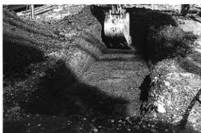
第 103 図 トレンチ掘削状況
