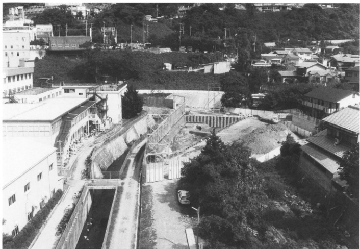
1. 調査地遠景 (西より)
