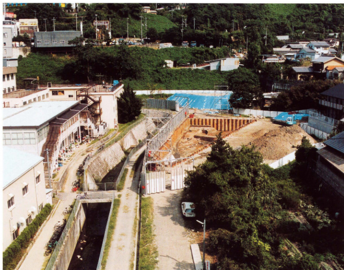
1. 調査地遠景（西より）
