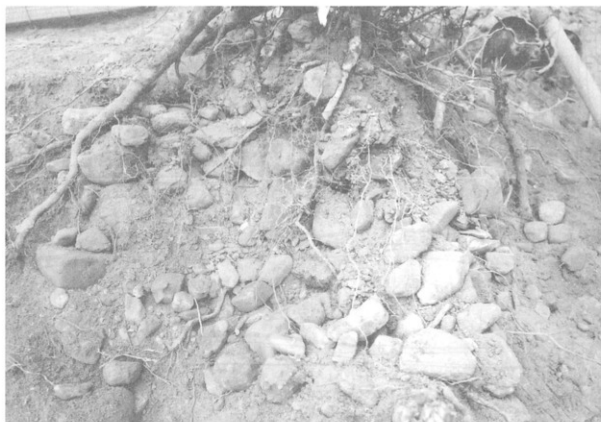
写真3 積み石の状況
