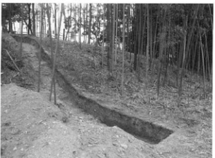
7. 第8トレンチ（東から）
