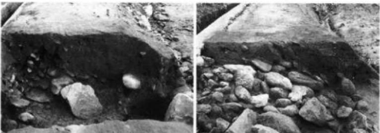
割石、野石等数種類の石が用いられている。I - II地点では大小の野石を乱積みした石垣が築かれている。崩壊した個所には裏込めの10~40cm大の礫が露出する。I - III地点は石垣が残っていない個所が多い。Fig.46に第3トレンチの土層を図示した。旧道は礫、砂質土の互層、小礫による裏込め、そして石垣の隙で築かれている。この旧道はI - III地点の西端で石敷きの登り口(右図版)が築かれ、現行の舗装道路に重なり、吸収される。
