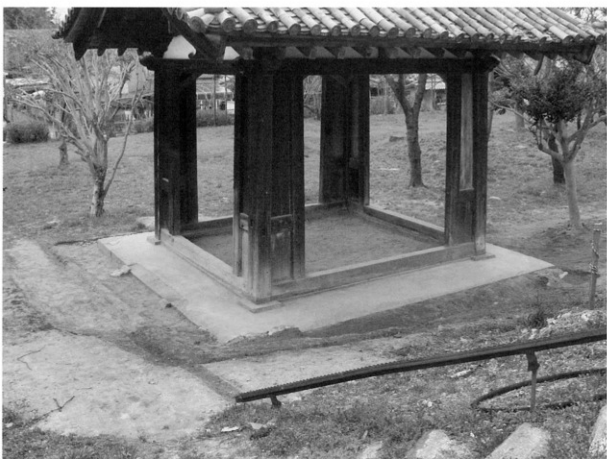
復旧後基壇(北東から)
