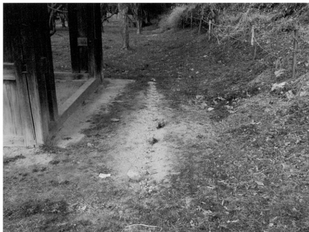
調査前 鐘樓北側
