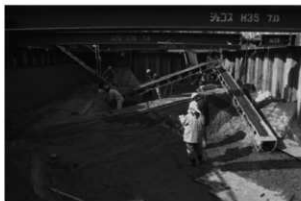
写真1 NG10-6次調査状況(東から)
