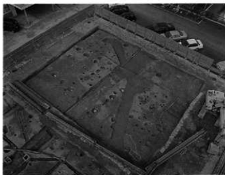
調査区東半全景 (南西から)
