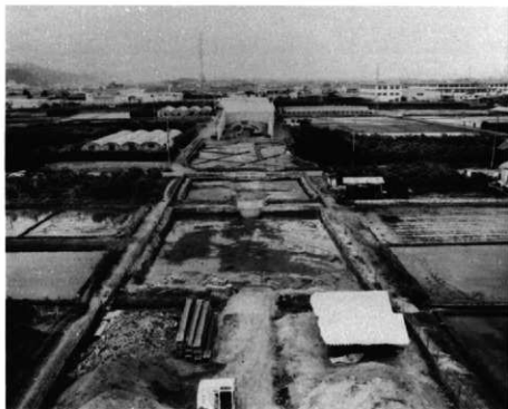
A・B区 全景 (南西より)
