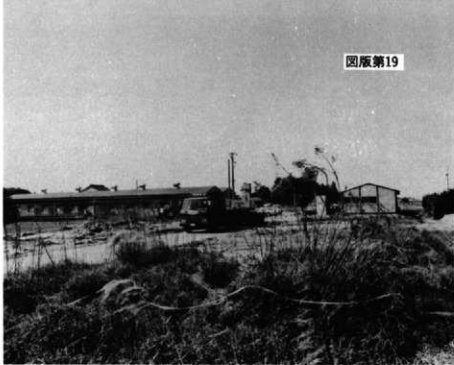
C区 表土掘削 (北より)
