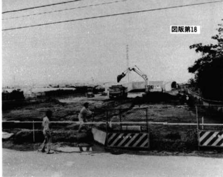
A区 表土掘削 (南より)
