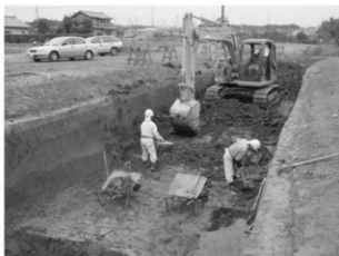
Fig.14 中層遺構検出作業
