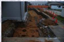
第7-2次調査全景（西から）
