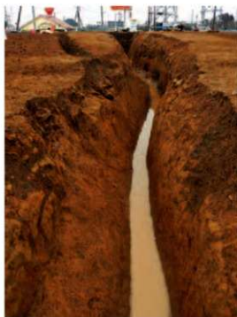
SD42b区 (西から)
