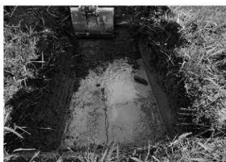
写真19 東浜原口地区トレンチ状況(南から)
