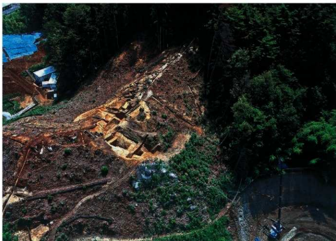
2区 SD201 遠景 (北西から)
