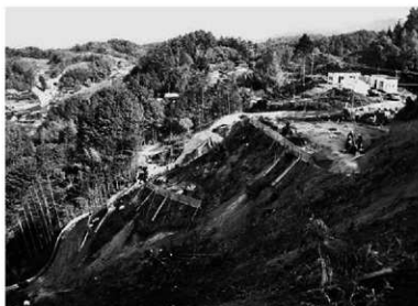
神之峯城跡1区 安全対策施設を設置しての調査風景
