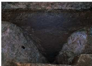
SD201 セクション (第170図 A-A) (南西から)
