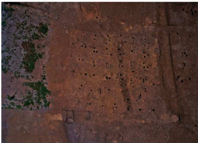
ST01 全景（写真上が北東）
