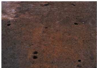
ST04 完掘 (南から)
