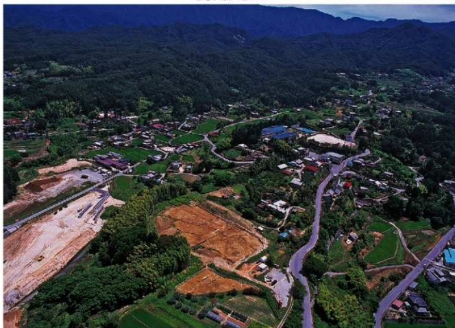
2-4区 遠景（北西から）
