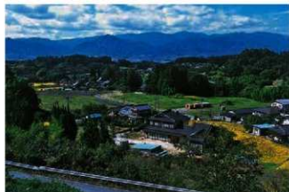
調査前風景 (南西から)
