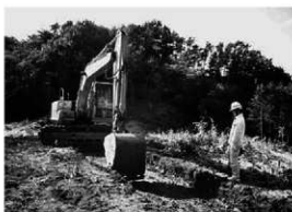
1区トレンチ掘削
