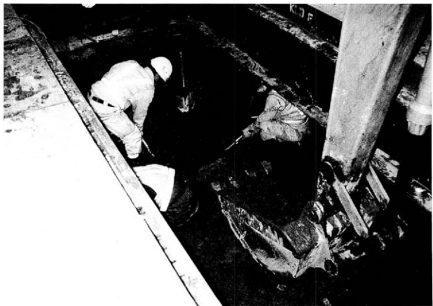
b 調査作業風景 (西から)
