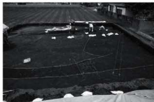
写真 4 遺構確認状況
