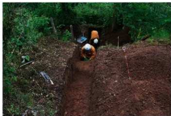
T5の掘削作業（西より）
