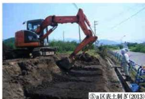
⑤a区表土剥ぎ(2013)
