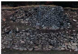
SH38-(1) 石垣 (西から)
