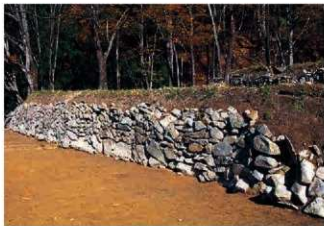
SH04 全景 (西から)
