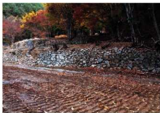
SH39 石垣全景 (南東から)
