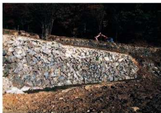
SH41 石垣全景 (西から)
