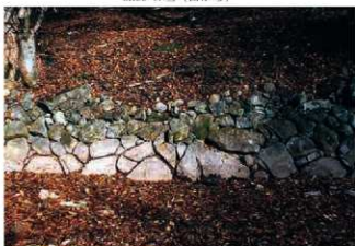
SH37-(1) 石垣 (西から)
