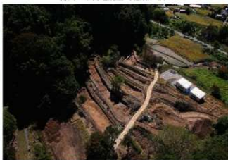
3・4区空撮 (北から)
