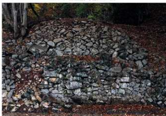
SH38-(2) 石垣 (西から)
