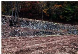
SH40 石垣全景 (西から)
