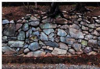
SH39-2) 石垣 (西から)
