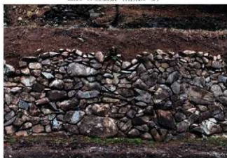
SH39-1) 石垣 (西から)
