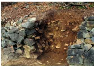
平地地5・SH01 トレンチ断面 (南から)
