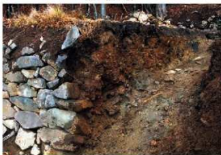
平地地6・SH03 トレンチ断面 (南から)
