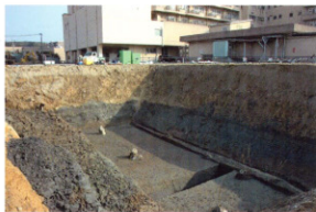
完掘状況から（北西から）
