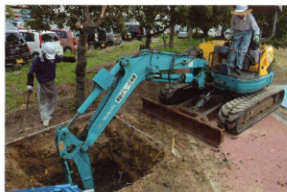
T3 掘削状況
