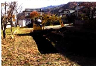
重機による埋め戻しの様子 (北から)
