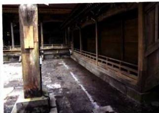
調査前（北西から）
