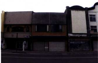
柳口周辺遺跡調査地解体前（東から）
