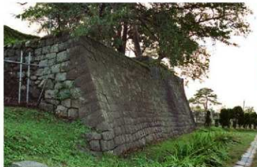
櫓跡北東側 石垣北東面（L・M面：北東から）
