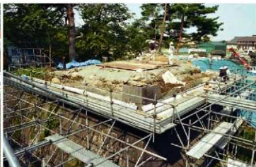
櫓跡上面埋戻し保護状況と石垣南辺・東辺上面検出作業 (南東から)
