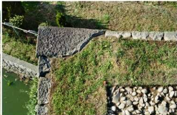
櫓跡石垣西角天端検出状況（南東から）
