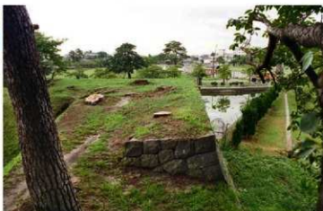
櫓跡北東面 つのや跡石垣 調査前 (北東から)
