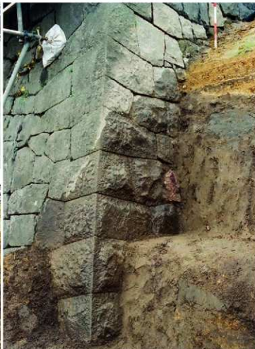
石垣北東角下部（北東から）
