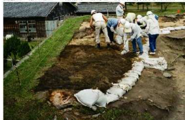
櫓跡上面 埋戻し保護作業 (南東から)
