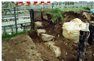
櫓跡南角 盛土内石垣 残存状況 (北東から)
