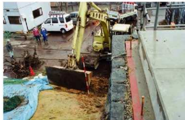
南トレンチ掘削（西から）
