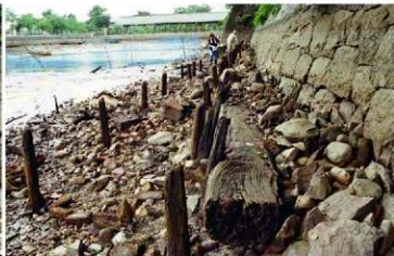
南側折南西面 石垣補強②横木・杭打ち (1面: 南東から)
