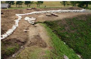
櫓跡上面 埋戻し保護完了 (南東から)
