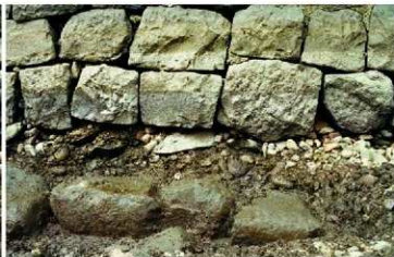
変形石垣と砂利による積み直し部 (E面：拡大，南から)
