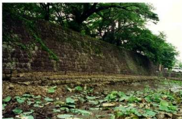
堀排水後の石垣前面の堀底検出状況（E面：表門西側、西南から）
