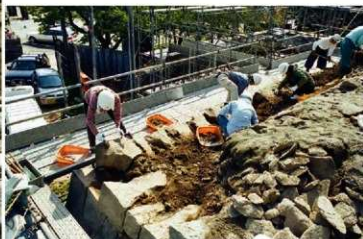
橋石垣北東部 切株除去後の上面精査作業
