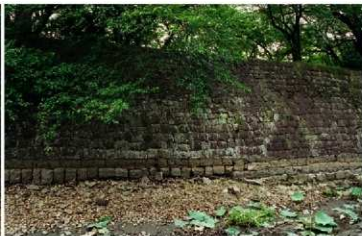
本丸南辺石垣（E面：旧二の丸隅櫓一表門間中央西寄り，南から）
