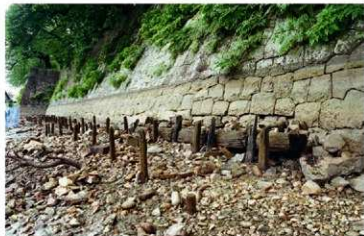
南側折南西面 石垣補強②・③横木・杭打ち留め (1面: 南から)
