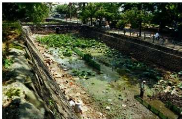
堀の排水と石垣前面の堀底検出（北西から）
