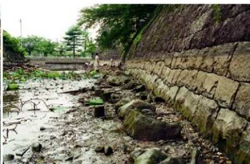
Dトレンチ置石・石垣補強①杭 検出状況 (E面: 東から)
