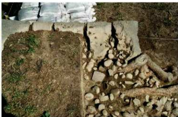
櫓跡東部 つのや跡北東端の石垣裏込め(南西から)
