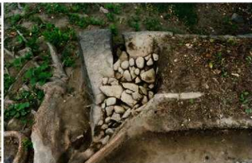
橋石垣北東角石・渠石(西から)
