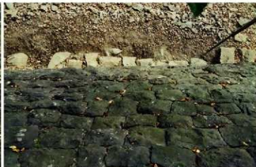
石垣下端変形①と上部積み直し部 (E面：西端，南上から)
