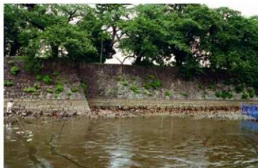
北側折南脇 石垣補強③ (1面: 南西から)
