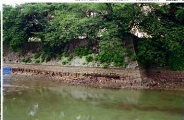
南側折南西面 石垣補強②・③ (1面: 南西から)
