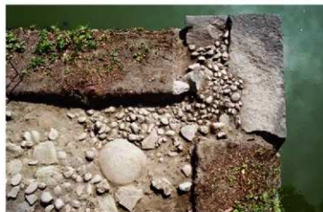
橋石垣南東角石・渠石（西から）
