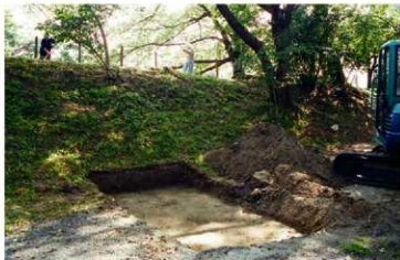
Cトレンチ全景（北東から）
