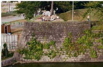
調査前の櫓跡遠景（南西から）
