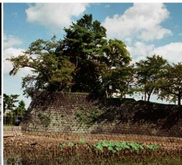
三階櫓跡 発掘調査前（平成12年夏 撮影、南西から）
