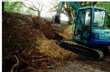
Aトレンチ掘削作業（北東から）
