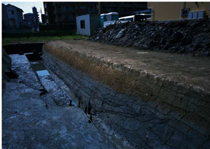
写真6 流路（15SR）完備状況、土層断面 -南東から-
