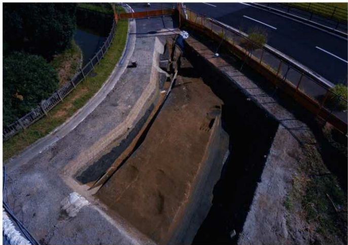
写真9 3区 新環線・道路検出状況 -北西から-
