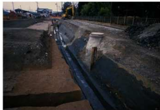
写真20 2・3区間畦除去後新環濠完成状況 -南から-
