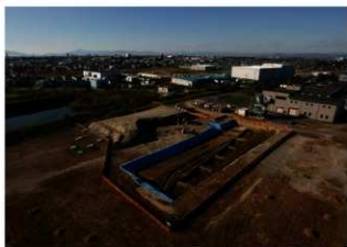
10区 1面遠景 (南東より)
