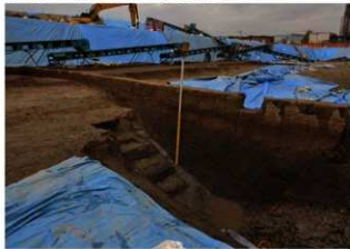
10区 3面 201NR (南東より)
