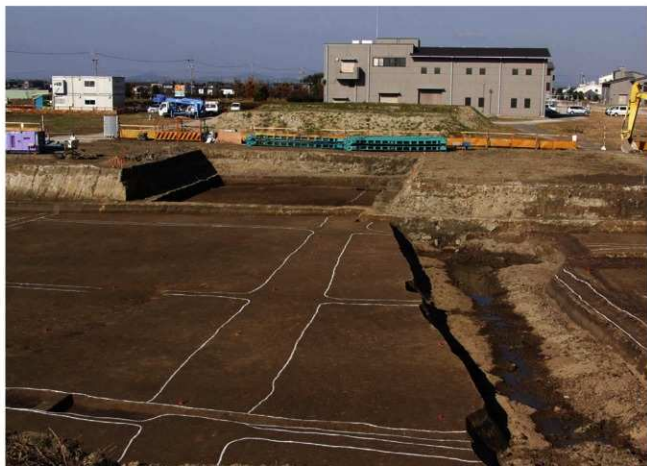
06区 1面 1052SX (南より)
