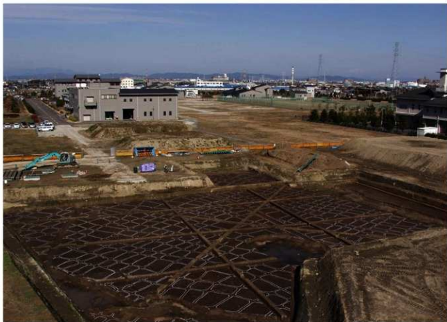
06区 2面全景（南西より）
