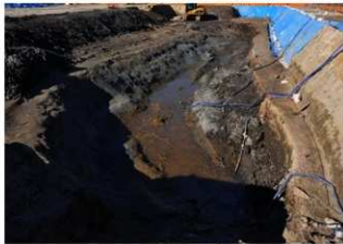
10区 3面 201NR (南より)
