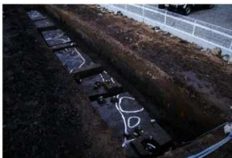
試掘5トレンチ 全景（南西から）
