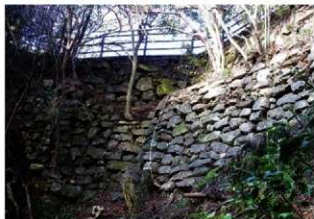
写真 9 岐阜城山城石垣
