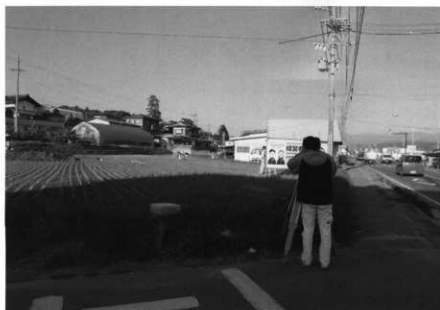
委託測量状況
