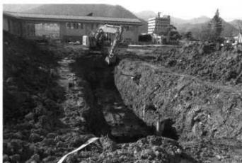
トレンチ掘削状況 (東より)
