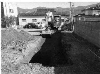
トレンチ掘削状況 (南西より)
