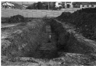
19号トレンチ検出状況（西より）
