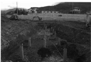
18号トレンチ検出状況（西より）
