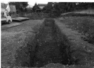
16号トレンチ検出状況（南より）
