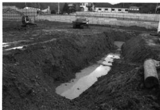
17号トレンチ検出状況（西より）
