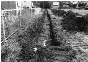
1号トレンチ検出状況 (西より)
