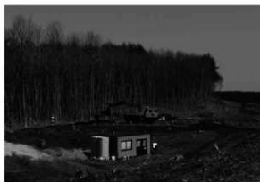
重機稼働風景
