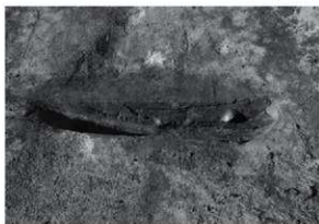
煙道断面（東から）
