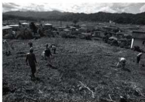
南西側 (S I 01 周辺) 現況 (東から)
