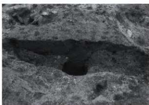
S K 60 断面 (東から)
