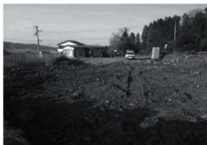
北調査区調査前現況（南から）
