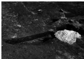
煙道断面北西→
