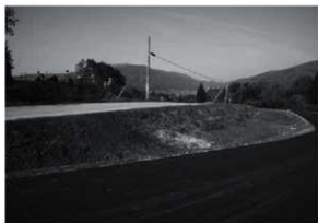
着手前の現道（南東から）
