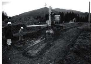
砕石盛土除去作業（北から）
