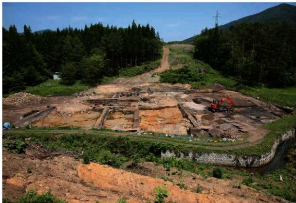
西区近景（西から）
