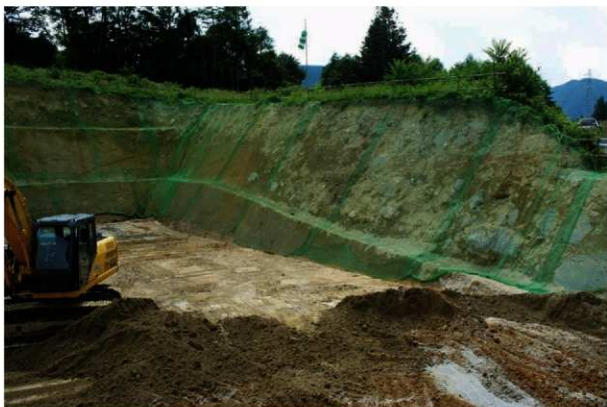
【図4-2】 高位緩斜面堆積物を切る斜面（高位緩斜面/L2面間の段丘崖）を覆う、低位緩斜面堆積物の露頭。写真右の露頭面に現れた花崗岩礫は芯まで風化しておらず、礫の切断面が凸凹している。
