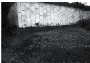
北側調査区調査前 (東から)
